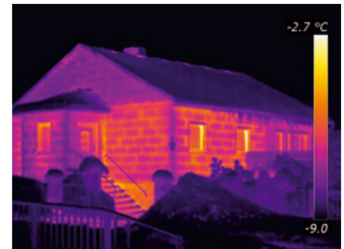
Thermografieaufnahme eines ungedämmten Massivbaus
