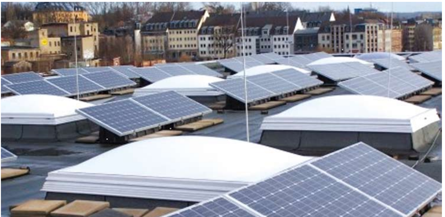
Bürgersolkraftwerk auf dem Depot des Chemnitzer Industriemuseums (Inbetriebnahme Dezember 2008); Quelle: Bernhard Herrmann (Bürgersolaranlage Chemnitz GbR)
