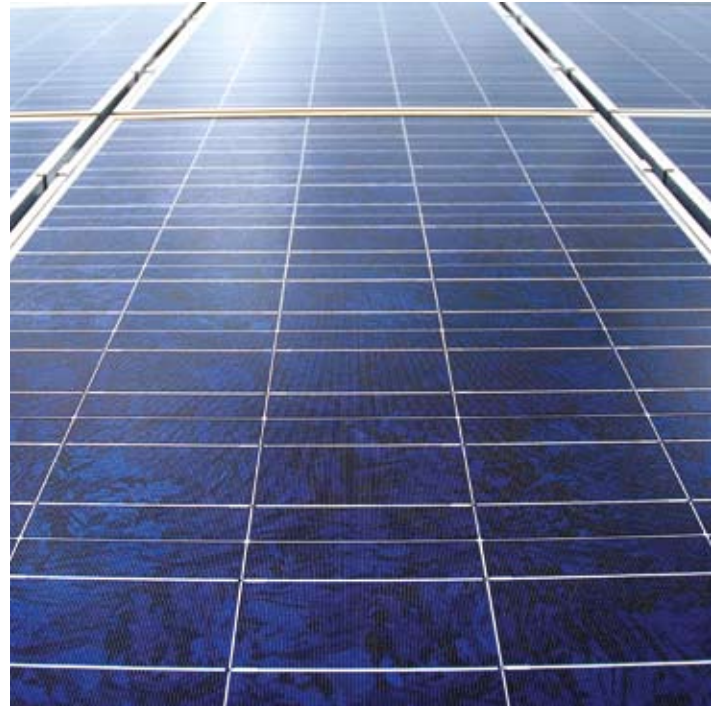
Nahaufnahme einer Photovoltaik-Anlage, bei der polykristalline Siliziumzellen zum Einsatz kamen. Die kristallinen Strukturen der Siliziumscheiben sind durch die unterschiedlich schimmernden Blautöne gut zu erkennen. Quelle: BSW-Solar/Upmann
