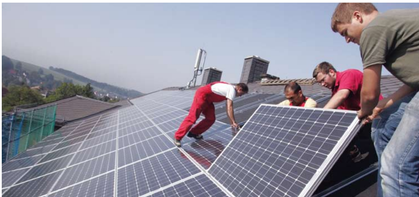
Montage des Bürgerkraftwerks auf der Geschwister-Scholl-Mittelschule in Roßwein im Oktober 2005; Quelle: Döbelner Allgemeine Zeitung
