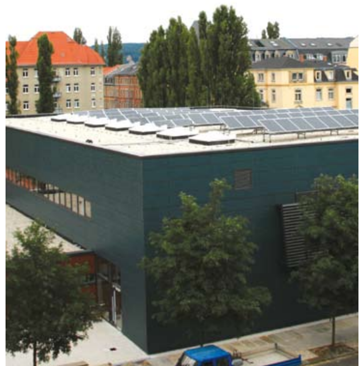
Bürgersolaranlage auf der Turnhalle des Martin-Andersen-Nexö Gymnasiums in Dresden (Inbetriebnahme Juni 2008); Quelle: SunStrom GmbH
