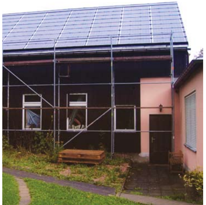
Bürgersolarkraftwerk Biotoppflegebasis Bärenstein (Inbetriebnahme Juli 2005); Quelle: Dietrich Papsch (Energietisch Altenberg e.V.)
